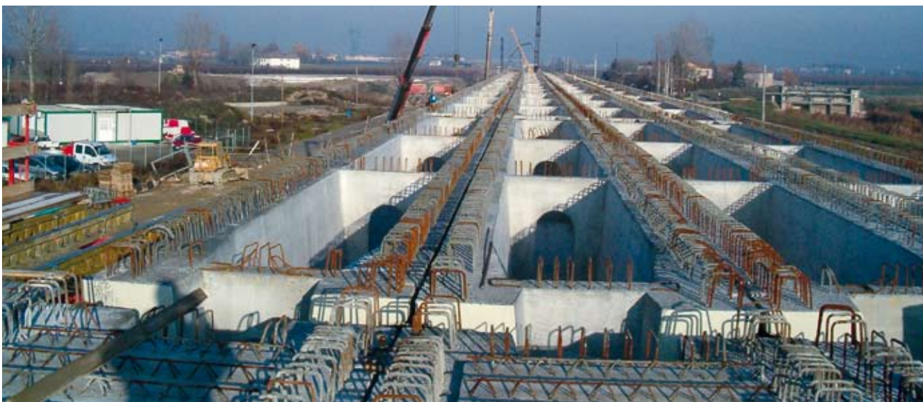
S. Agata Bolognese (Bo), viadotto ferroviario "Crocetta S. Agata"
