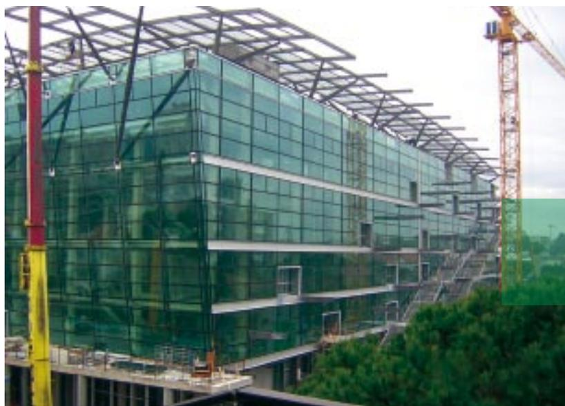
L'edificio è composto da un'imponente struttura in cemento armato e acciaio interamente rivestita di vetro (9.000 mq) sul perimetro esterno; un nastro frangisole che ombreggia la terrazza di copertura, la piazza sottostante ed un imponente scudo a botte che protegge la facciata sud.
