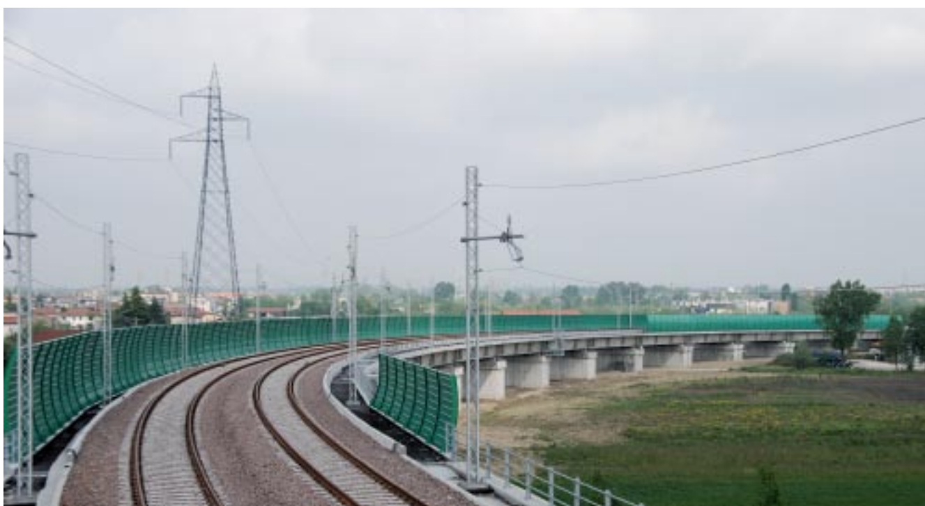
Viadotto ferroviario, Mestre
