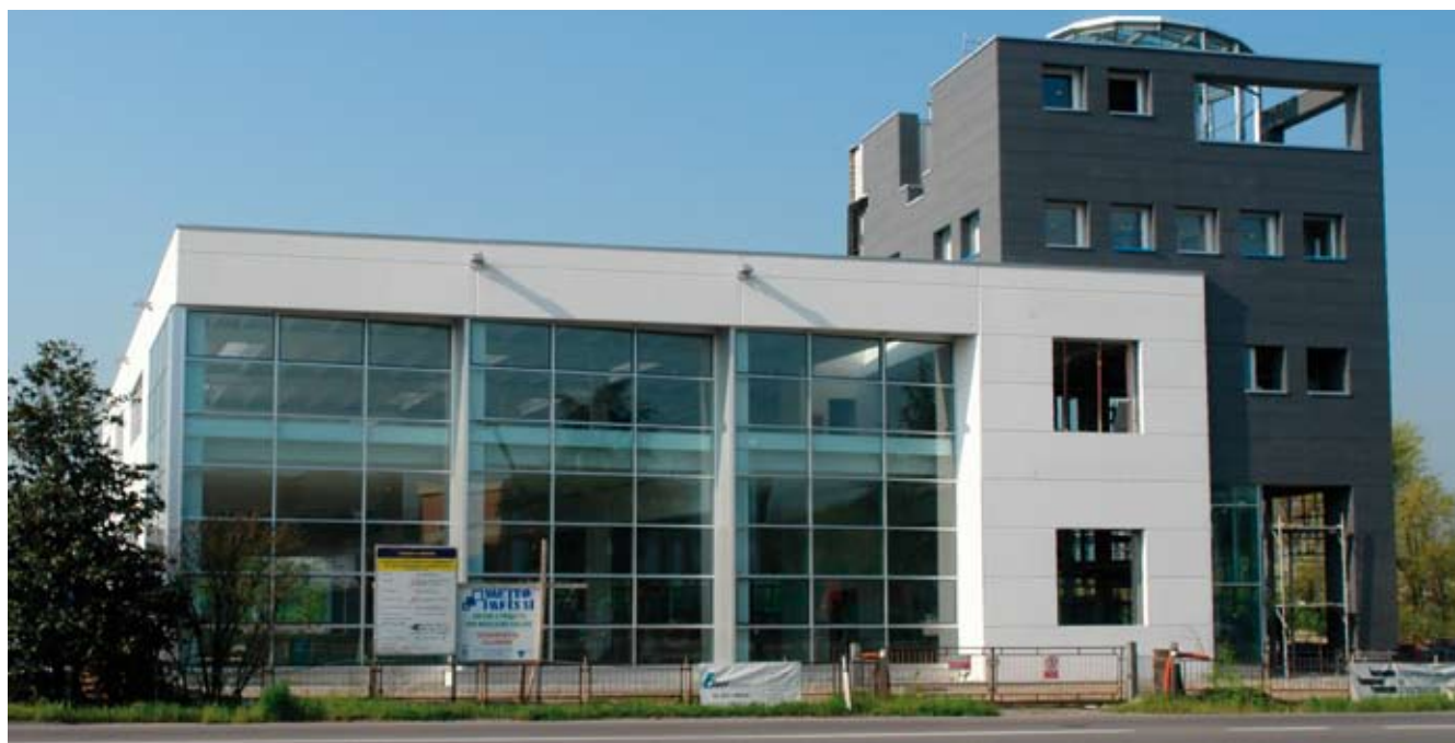
Modena, prefabbricato The Brick
